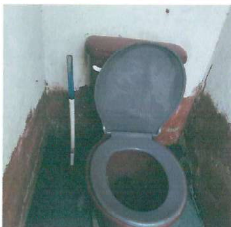
Foto 1: Mejoramiento de servicios sanitarios y sus accesorios
