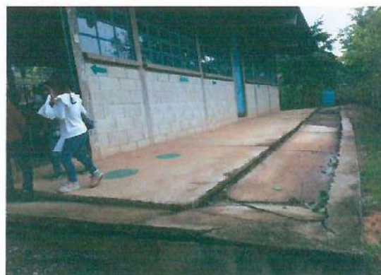
Foto 4: Mejoramiento de piso en Aula Anexa
